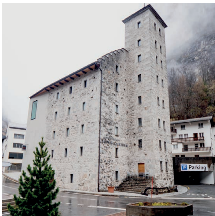
In Gondo sollen Elektroheizungen zunehmend aus den Gebäuden verschwinden.
